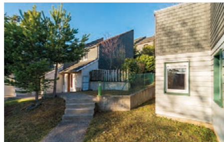
Logements en duplex
