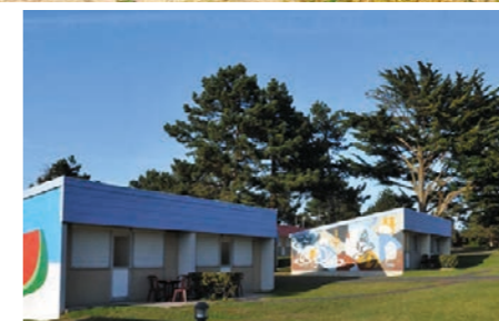
Pavillons avec façades aux fresques colorées.
