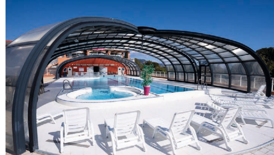
Piscine couverte de la Résidence. Ouverte et chauffée toute l'année
