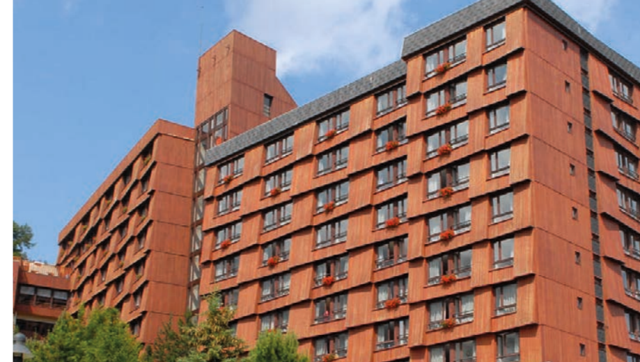
Complexe de 8 étages à 1 600 m d'altitude de la station
